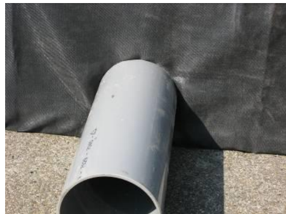
Bild 4: Koppling av rör till kassett.
