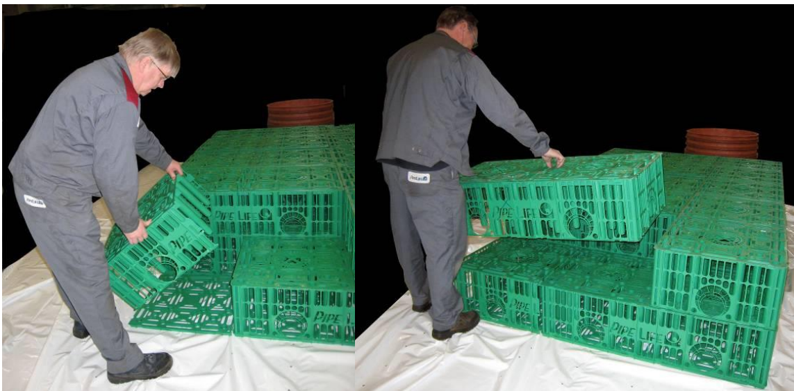
Bild 2a och 2b: Kassetterna kan halveras och infogas i anläggningen.
