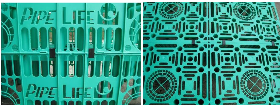
Bild 3a och 3b: Åtminstone 2 clips i vardera riktning skall monteras för att hålla boxarna på plats och uppnå erforderlig styrka.
